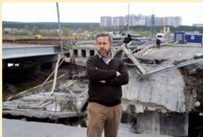
Předseda zahraniční komise Pavel Branda při návštěvě míst poničených při ruské ofenzivě v Kyjevské oblasti (na pozadí Romanivský most přes řeku Irpiň, který ve snaze zpomalit ruský postup na Kyjev vyhodila do vzduchu ukrajinská armáda a který již prochází opravou) – 19. 4. 2023
