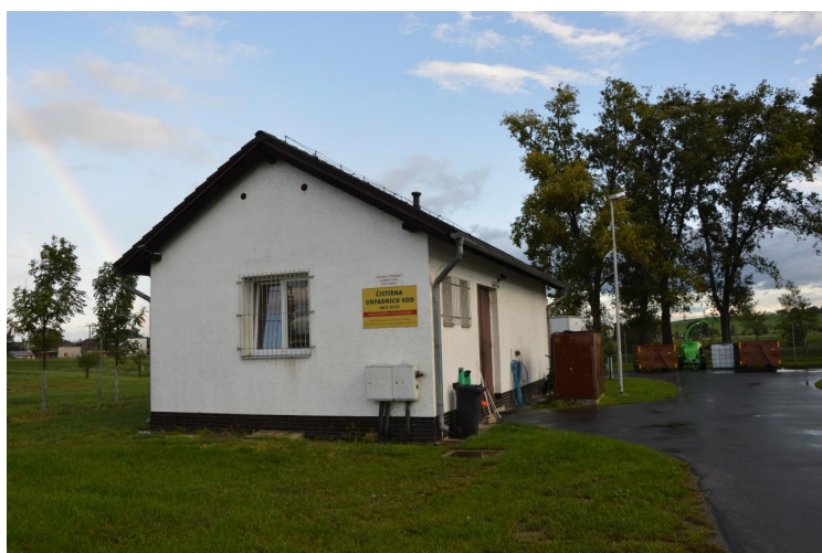
Obrázek 21. Čistírna odpadních vod
