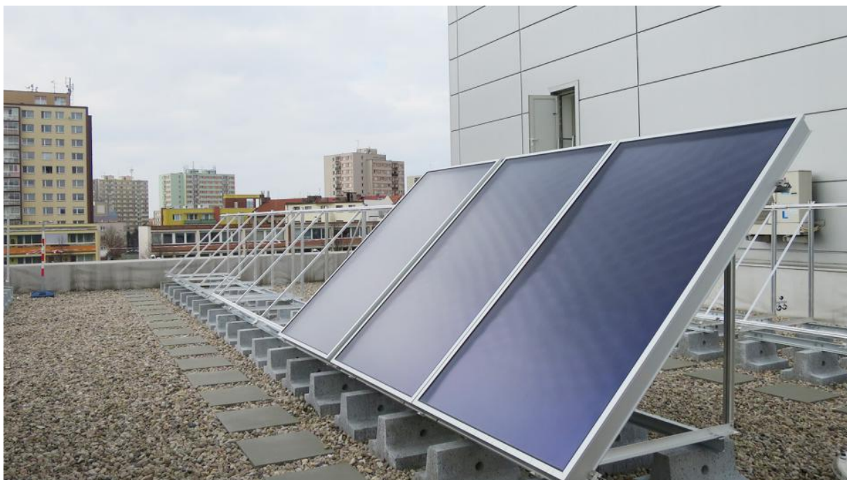
Obrázek 14. Solární panely sloužící pro vytápění AQUACENTRA
