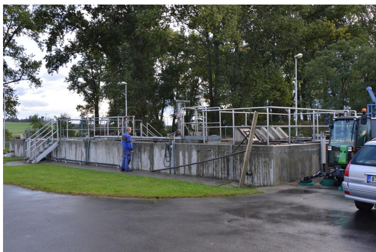
Obrázek 20. Čistírna odpadních vod
