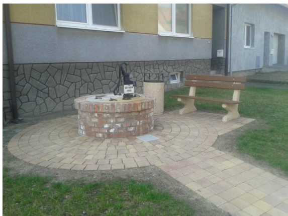
Obrázek 47 Zrekonstruovaná studna Ratíškovice, (zdroj: vlastní fotodokumentace, 2014)
