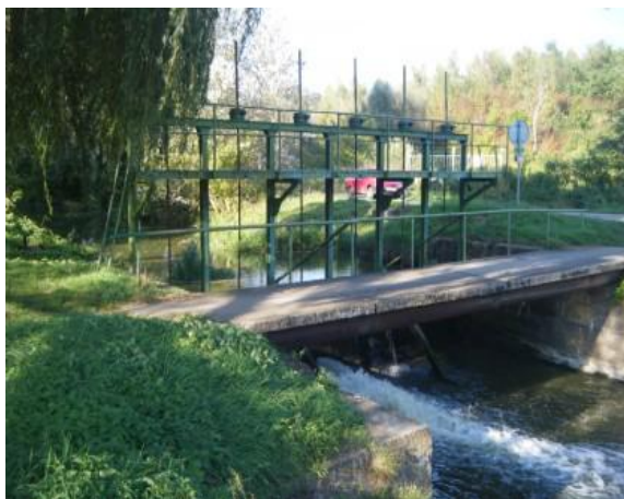
Obrázek 42 Hodonín - ocelová potrubní lávka (zdroj: JMK, 2013)
