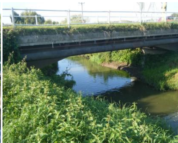
Obrázek 43 Hodonín - hospodářský most železobetonový (zdroj: JMK, 2013)
