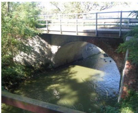
Obrázek 41 Mutěnice - cestní most (zdroj: JMK, 2013)
